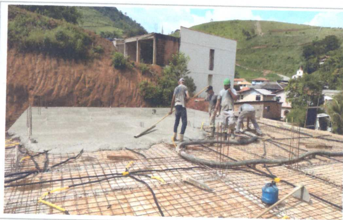
CONCRETAGEM DA LAJE
