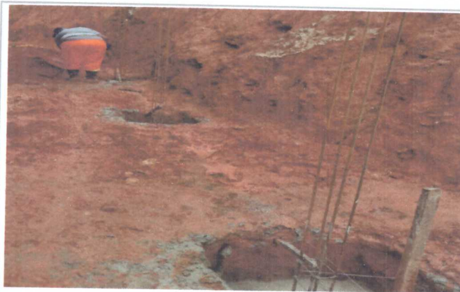
CONCRETAGEM DAS SAPATAS DO MURO
