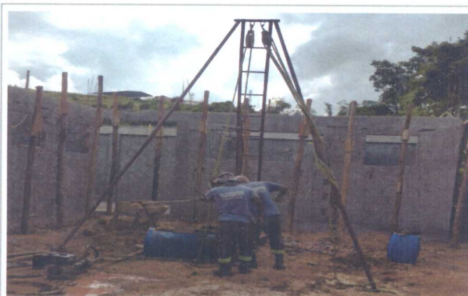
EXECUÇÃO DA SONDAGEM A PERCUSSÃO
