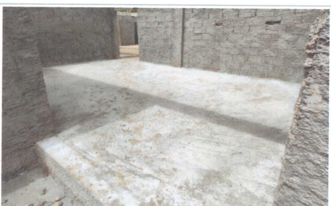
Piso concretado (magro)
