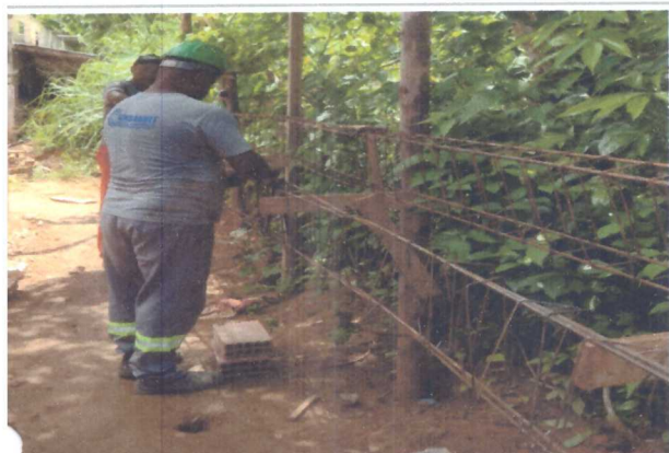
REALIZAÇÃO DA DOBRA DE FERRAGEM DAS VIGAS DE CINTAMENTO
