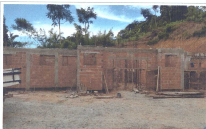
Vigas de cimento concretadas
