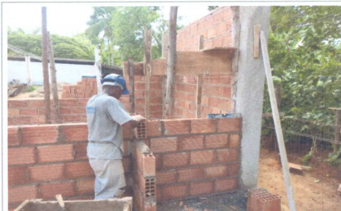
ASSENTAMENTO DE TIJOLO CERÂMICO
