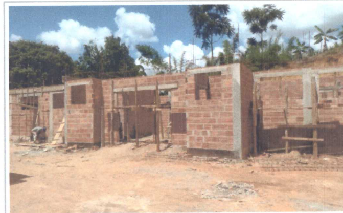
INSTALAÇÃO DAS VIGAS DE CINTAMENTO
