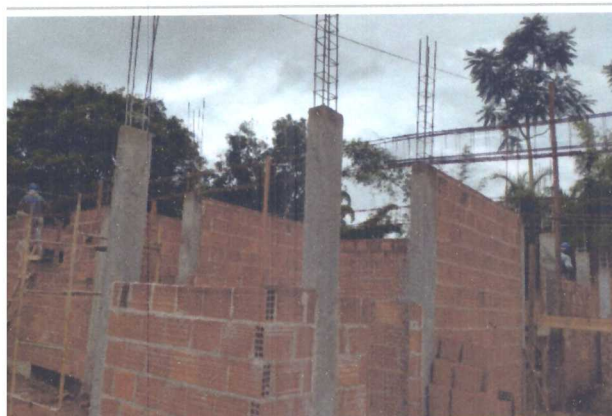
INSTALAÇÃO DAS VIGAS DE CINTAMENTO
