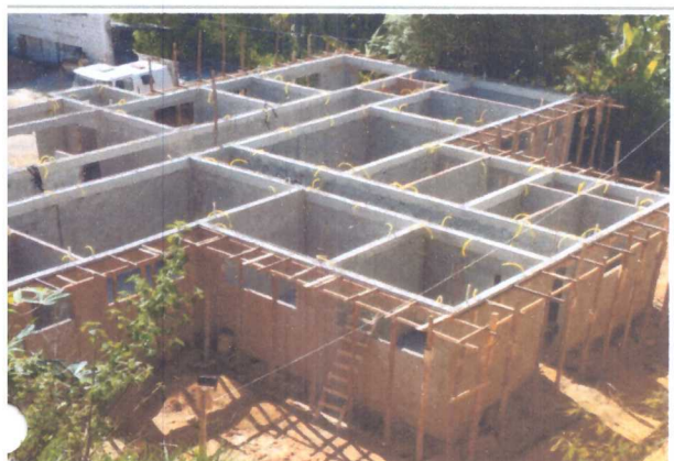
ESCORAMENTO DO BEIRAL
