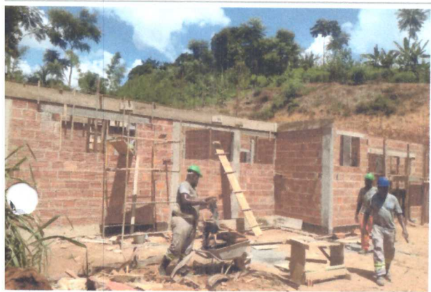
Montagem das formas das vigas de cimento
