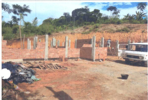
ASSENTAMENTO DE TIJOLO CERÂMICO
