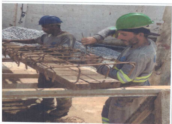
TE, DOBRA DE FERRAGEM DO RADIER DO MURO
