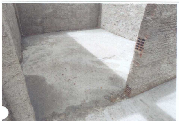
Piso concretado (magro)
