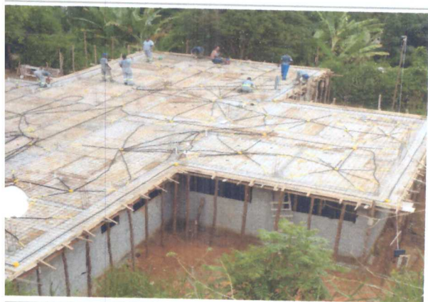
ONDUITES E CAIXAS DE LUZ INSTALADOS NA LAJE
