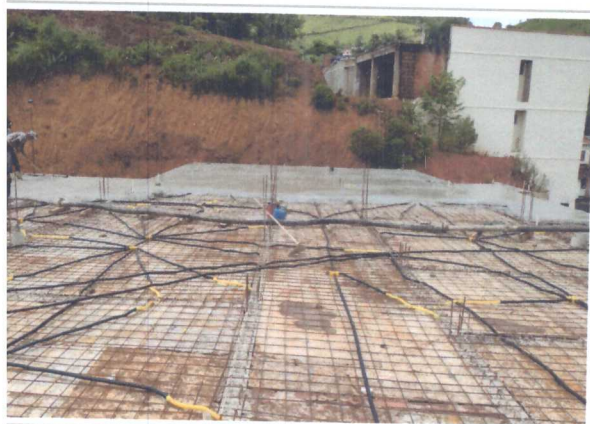
CONCRETAGEM DA LAJE
