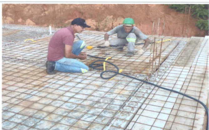
INSTALAÇÃO DE CONDUITES E CAIXAS DE LUZ NA LAJE
