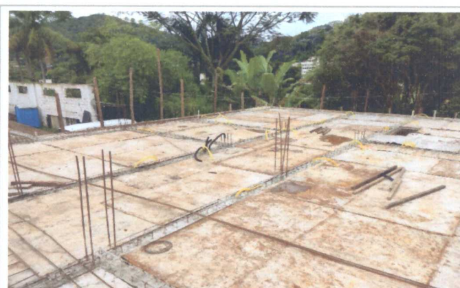
MONDAGEM DA LAJE MACIÇA
