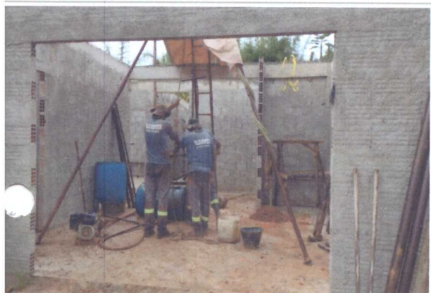
EXECUÇÃO DA SONDAGEM A PERCUSSÃO
